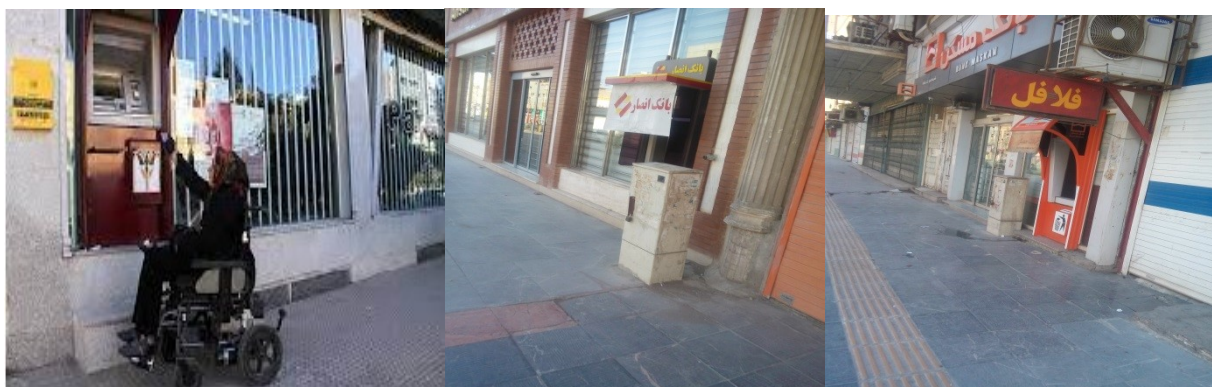
شکل ۷: ارتفاع زیاد دستگاه‌های خودپرداز از سطح زمین و نبود رمپ مناسب
