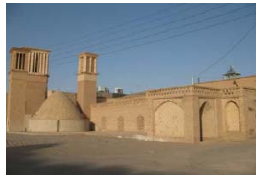
شکل ۹- بافت تاریخی شهر نائین (گرم و خشک)، نقشمایه‌های معماری شهری هم در مقیاس کلان و هم در مقیاس خرد، نقش مؤثری در کیفیت‌زایی و هویت‌بخشی فضاها و جداره‌های شهری دارند.
