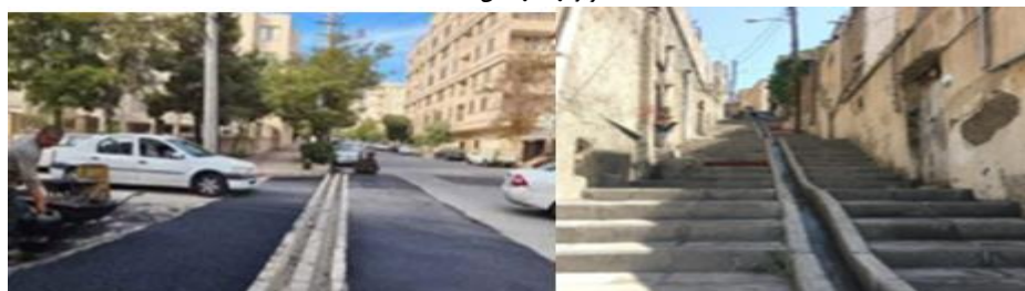
شکل ۳. پله‌سازی پیاده‌روها و آسفالت خيابان شريعتی
