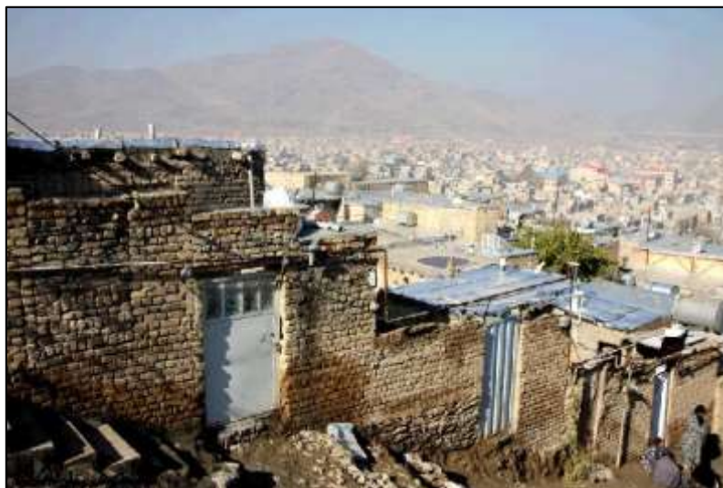
شکل ۴. نمایی از سکونتگاه غیررسمی در حریم شهر کرمان
