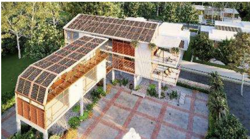
شکل ۵- نمونه‌ی اجراشده‌ی پنل‌ها با زوایای مختلف در یک ویلا مسکونی (نگارندگان)
