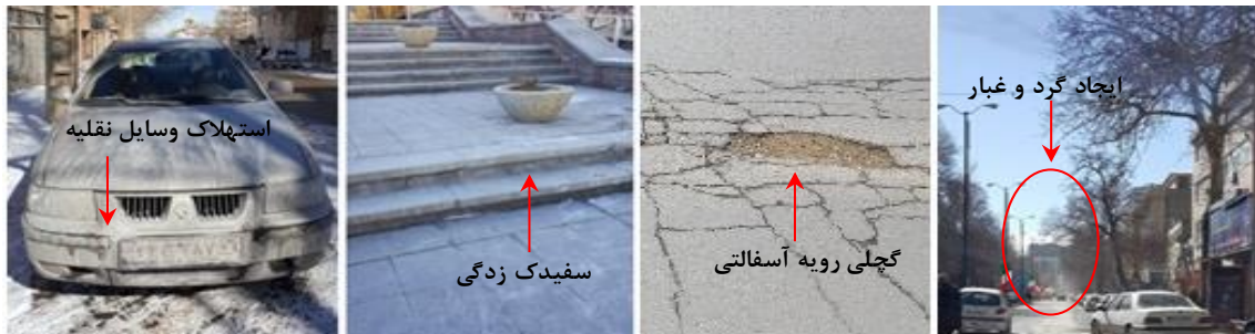
شکل ۱- نمونه‌هایی از خسارات محیطی پاشش مخلوط ماسه-نمک در فصل زمستان شهر همدان Figure 1. Some cases of environmental damages caused by winter maintenance in Hamedan
