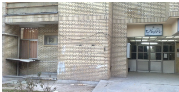
شکل ۸. ساکنان اتاق‌های کنار ورودی برای تأمین محرمت مجبورند تمام مدت با کشیدن پرده‌های اتاق، خود را از نور طبیعی محروم سازند.
