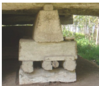
شکل ۹. اجزای مختلف پی شیکیلی (مأخذ: خاکپور، ۱۳۸۵)
