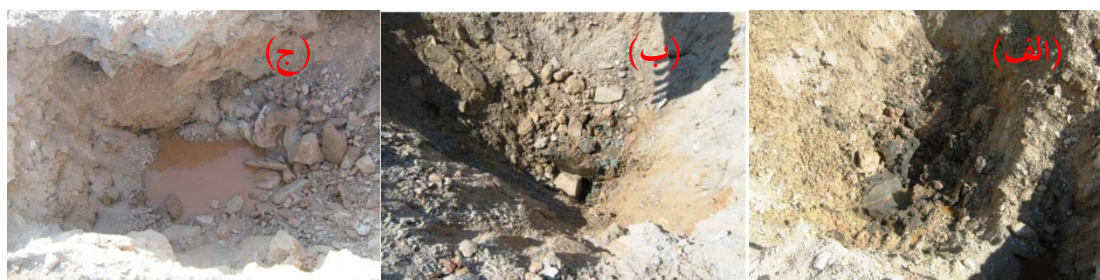
شکل ۱۶- الف) گودال‌های حفر شده در سنگ باطله تا رسیدن به سطح باطله در استراتژی الف) اول، ب) دوم و ج) سوم (۲۸)
