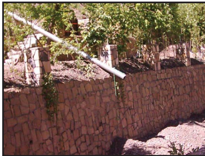
شکل ۵: انتقال واریزه ها از طریق لوله های پلی اتیلین از روی دامنه ها به بستر رودخانه (مأخذ: نگارندگان، ۱۳۹۳)
