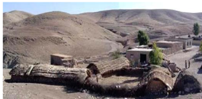
تصویر ۶: منظره‌ای از خانه‌های مسکونی در روستای گزمازی
