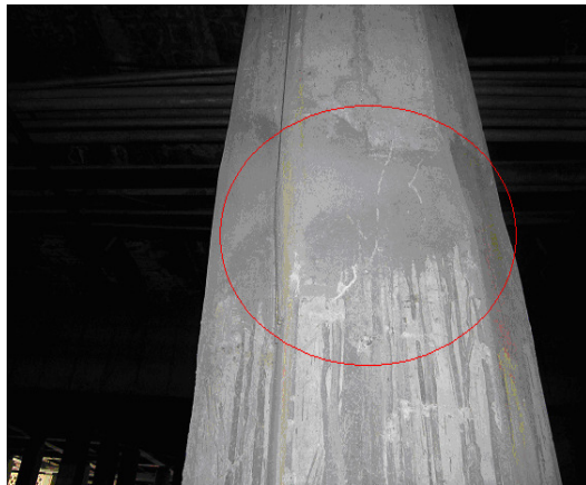
ب: وجود انحنای و عدم اجرای صحیح ستون دیده می‌شود.
