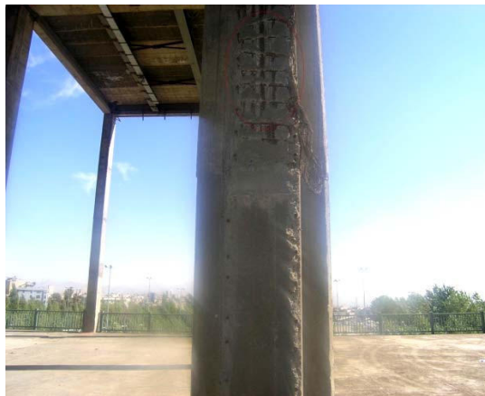
د: فرسودگی و عدم پوشش کافی ستون دیده می‌شود.
