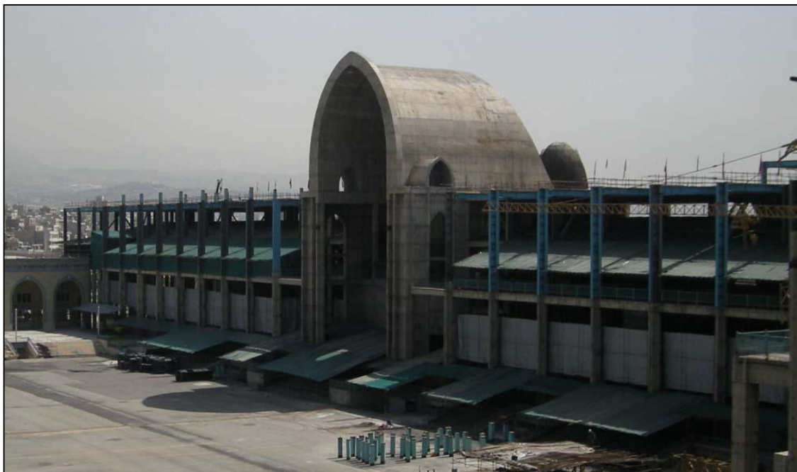
شکل ۲- ساختمان رواق شرقی مصلی تهران
