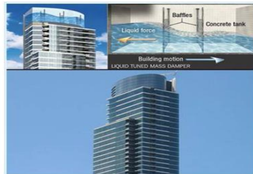
شکل ۱- برج مسکونی One Rincon Hill (سانفرانسیسکو) مجهز به سیستم TLD (صوری، ۱۳۸۰)
