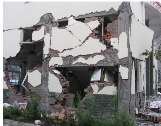
شکل ۲- شکست برشی تیر به علت تقابل با دیوار پرکننده آجری غیر ضخیم
