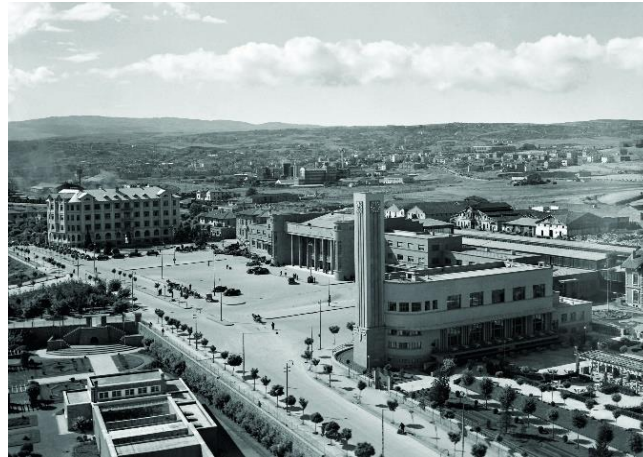
شکل ۴. ایستگاه راه‌آهن آنکارا؛ ترکیه - (مأخذ: عربانی، مقدس‌نژاد، ۱۳۹۳)
