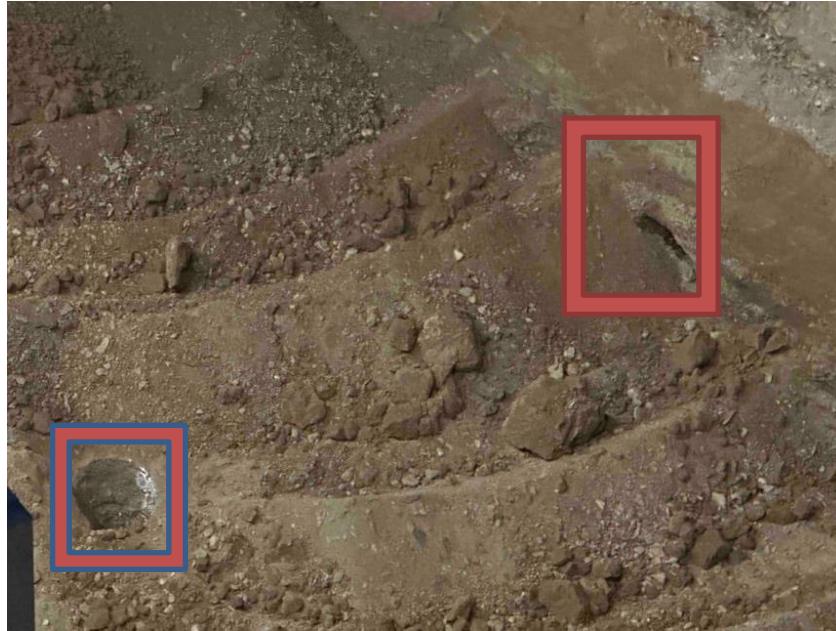
شکل ۴. مجرای قنات طیفوری در محله درب کوشک که در اثر گودبرداری بیرون آمد (عکاس: نگارنده، ۱۴۰۳).
