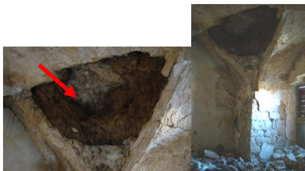
شکل ۱۷- فاصله‌ی بین تاق‌ها از کود حیوانی پر شده است
