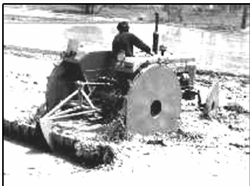
شکل ۴- عملیات ماله‌زنی با چرخ آهنی
