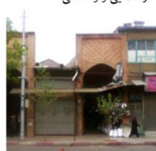
تصویر شماره ۱۸: وجود سایه اندازهای نامناسب در ضلع شرقی
