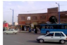
تصویر شماره ۶: فرسودگی کالبدی شدید
