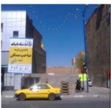
تصویر شماره ۲۰: افزایش زمین های بایر و فرسودگی شدید بناها
