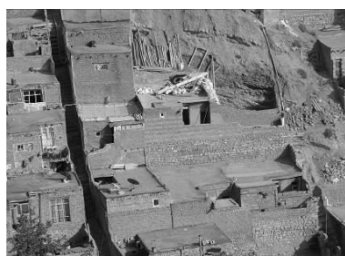
شکل شماره (۸): قرارگیری بر روی شیب نامناسب
