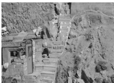
شکل شماره (۲): موقعیت ارتباطی نامناسب واحدهای مسکونی
