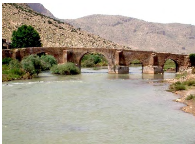
تصویر ۱۶: تصویر ۱: پل بیستون (عکس از مژگان خانمرادی).
