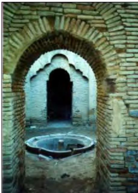
تصویر ۱۳: نمایی از داخل حیاط آشپزخانه عمارت خسروآباد (عکس از نگارنده، ۱۳۸۸).
