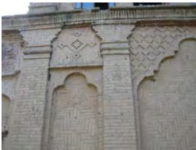
تصویر ۱۷: بخشی از نمای شرقی قصر در عمارت خسروآباد که احتمالاً آجر لعابدار داشته است (عکس از نگارنده، ۱۳۸۹).
