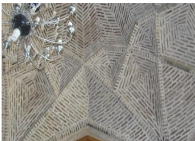
تصویر ۲: کاربندی سقف هشتی کاروانسرای نیشابور (عکس از نگارندگان).
