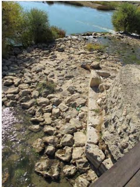
تصویر ۸: بستر سازی در پل خسرو (عکس از نگارنده).
