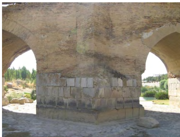
تصویر ۲: نمونه‌ای از آبشکن‌های مثلثی شکل پل بیستون (مرمت‌هایی در دوران اسلامی بر روی آن صورت گرفته است (عکس از نگارنده).
