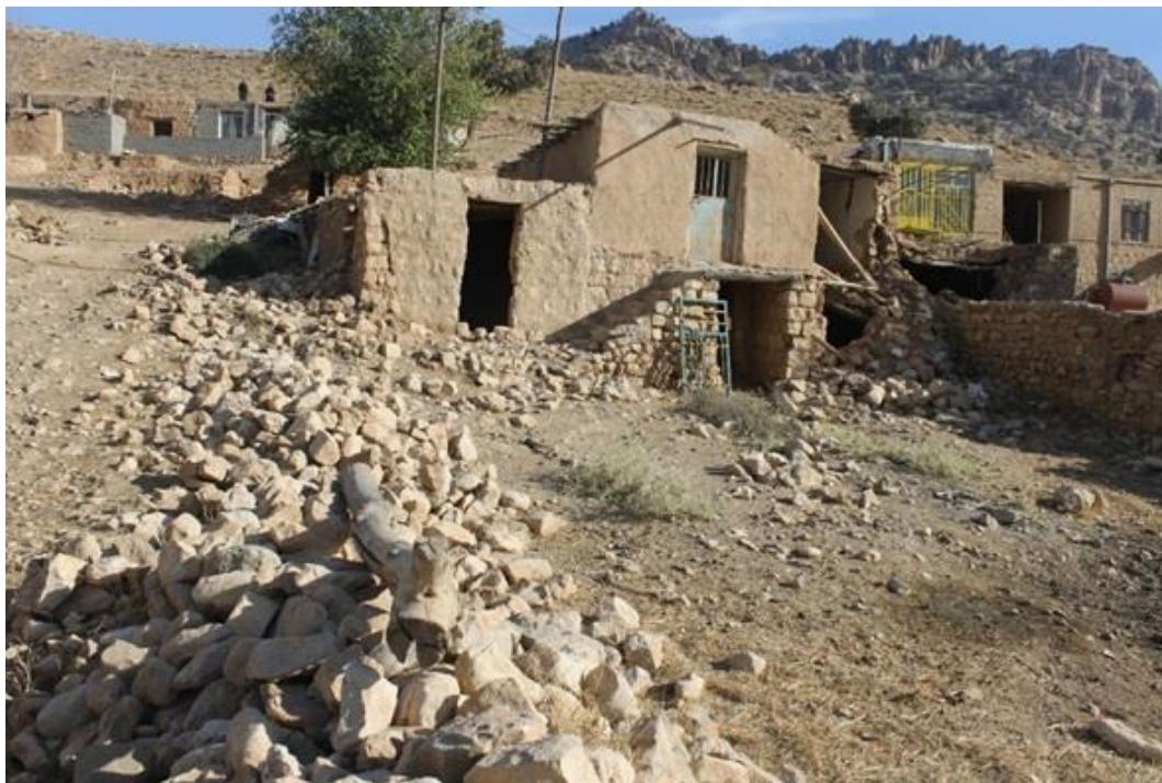
شکل ۳: خانه‌ای که مدت ۱۵ سال است که متروک شده و نخاله‌های آن برجای و دست‌نخورده باقی مانده است (روستای ناوتنگ)
