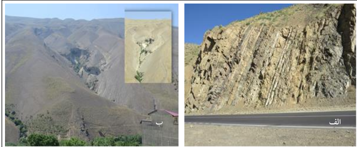
شکل ۲- الف، لایه بندی های سنگ های آذر آواری در سازند کرج (ترانشه های مسیر جاده منطقه مورد مطالعه - دید به سمت شمال). ب، نمونه ای از لغزش توده ای در منطقه مورد مطالعه، جاده کشار (دید به سمت جنوب).
