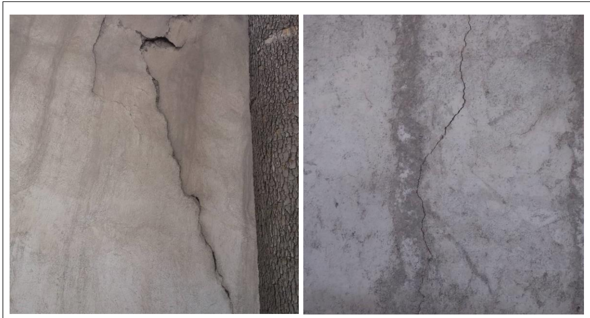
شکل ۹- ترک‌های ایجاد شده در دیوار باغ بر اثر پدیده فرونشست زمین در دشت شهریار
