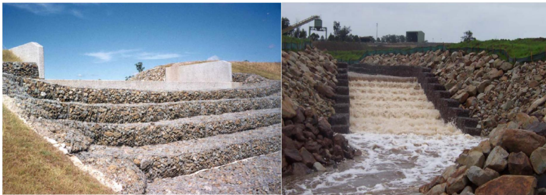
شکل 2: نمونه‌ای دیگر از سرریز پلکانی گابیونی
