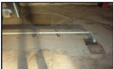
شکل ۳: تخلیه فلوم به سیستم زهکش کف آزمایشگاه
