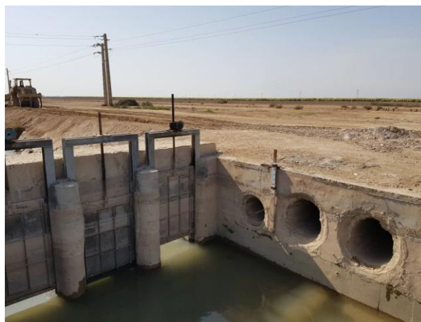
شکل ۲: تصویری از سازه ساخته شده برای انتقال آب زهکش به کانال آبیاری
