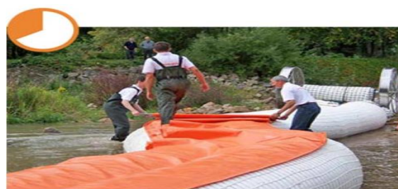
شکل ۱۰- گام سوم نصب سیل بندهای MOBILDEICH
