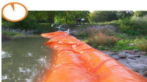
شکل ۱۱- گام چهارم نصب سیل بندهای MOBILDEICH
