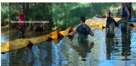
شکل ۱۵- مسدود نمودن مسیر رودخانه با استفاده از سیل‌بندهای پارچه‌ای
