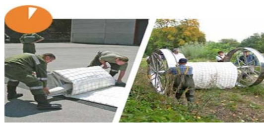
شکل ۸- گام اول نصب سیل بندهای MOBILDEICH
