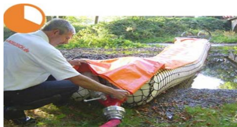
شکل ۹- گام دوم نصب سیل بندهای MOBILDEICH
