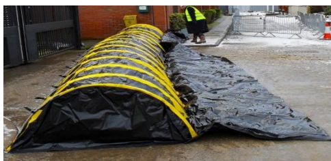
شکل ۲۰- نحوه نصب سیل‌بندهای تیوبی خودپرشونده
