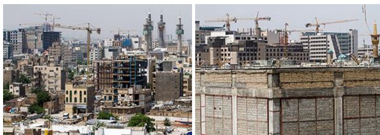
شکل ۱۵: پنهان شدن مجموعه حرم در میان ساخت‌وسازهای فاقد هویت و تخریب گسترده در بافت سنتی، (منبع: ناظری: ۱۳۹۴)
