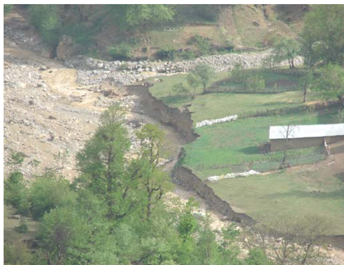
شکل شماره ۱۶- عکس فرسایش کناره ای در غرب حوضه (روستای رینه)
