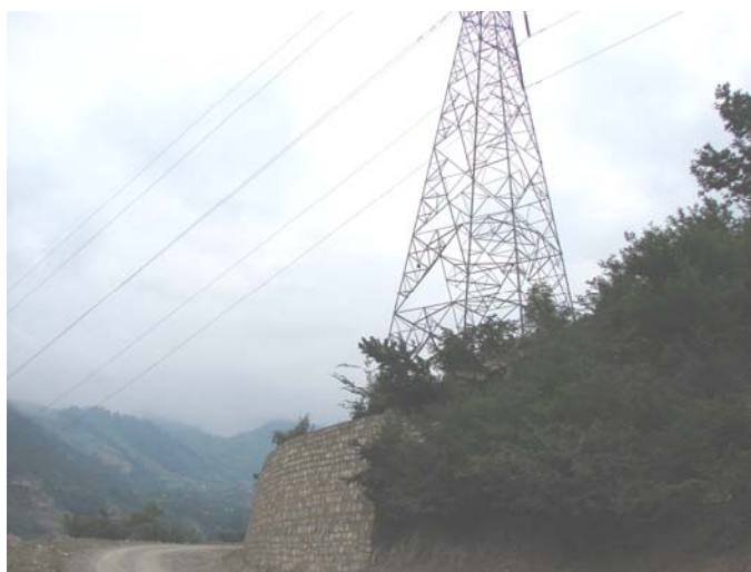
شکل شماره ۱۵- عکس تهدید دکل فشار قوی برق بر اثر پدیده لغزش
