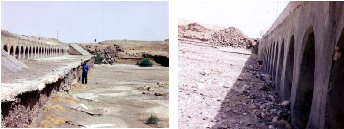
شکل ۶- کانال اصلی یکی از مخروط افکنه‌های منطقه (رودخانه سرگردان) قبل و بعد از پل احداثی
