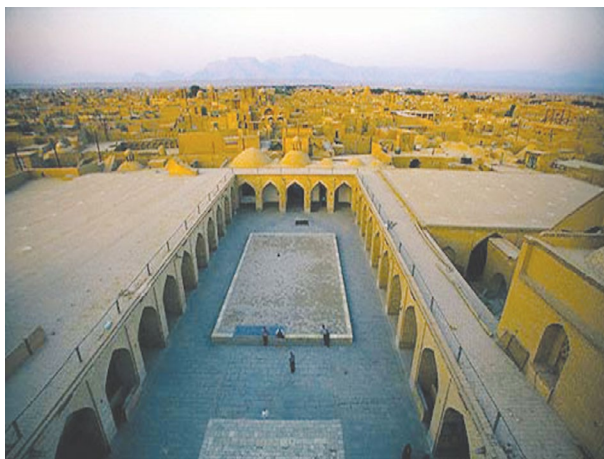
شکل ۲. ریتم در مسجد جامع یزد
