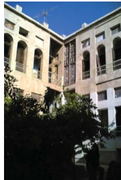
شکل ۱۵. بازشوها در جداره داخلی. بافت قدیم بوشهر. محله کوتی. خانه دهدشتی
