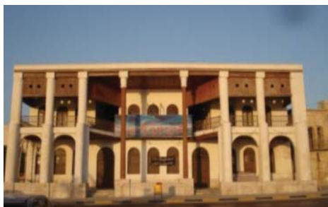
شکل ۱۸. پنجره های بزرگ خارجی با بازشوهایی در قسمت فوقانی برای تهویه فضاها. بافت قدیم بوشهر. محله کوتی - ساختمان امیریه
