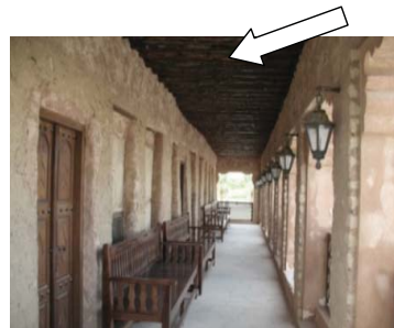
شکل ۲۳. پوشش سقف اتاقها از چوب « چندل » و حصير. محله بستکيه - دبي
