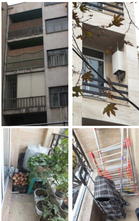
شکل ۷. ناکارآمدی تراس‌های موجود و اختشاش سیمای ساختمان
