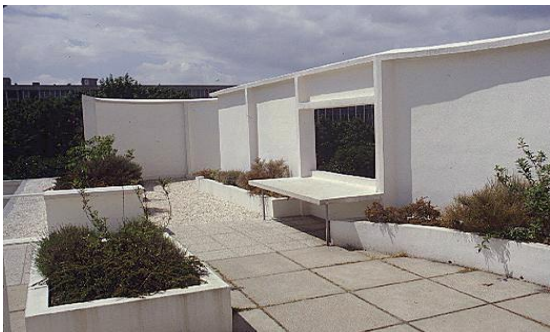
شکل (۲): تصاویر بام و نمای ساختمان ویلا ساووا
