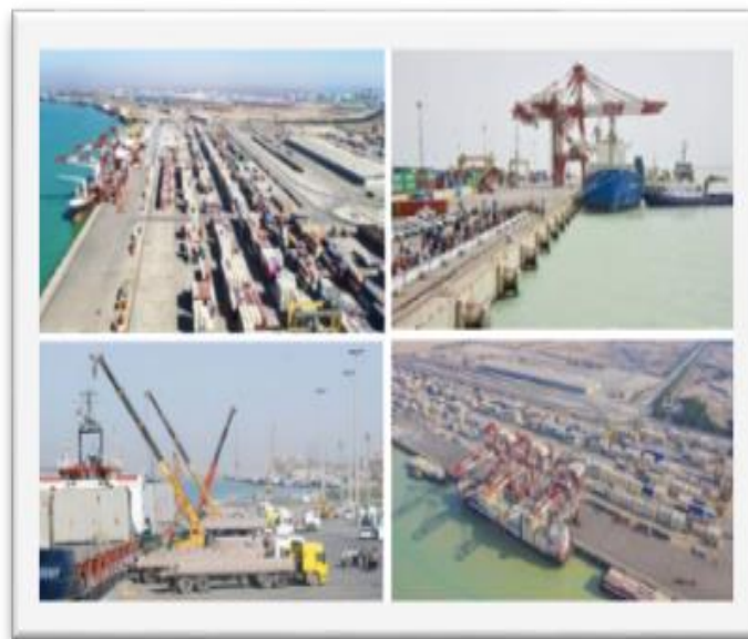
شکل ۴. اسکله و انبارها و محوطه بارگیری و تخلیه بار بندر امام خمینی (ره)
