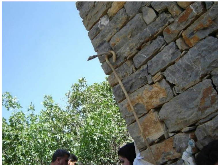
شکل ۳- اجرای خشک چین سنگ - آرامگاه پیر شالیار - اورامان تخت
