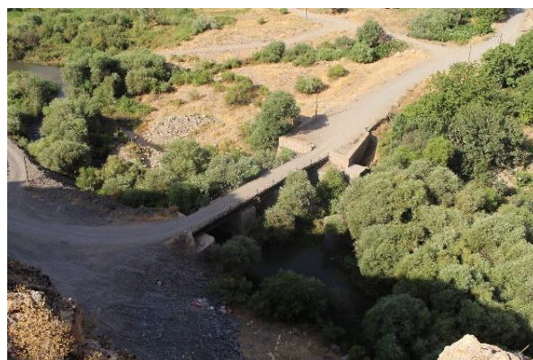
شکل ۲۱: پل درویش بگ (طالب‌نیا، ۱۴۰۰)
