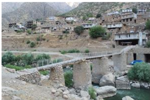
شکل ۴: پل دیوزناو (طالب‌نیا، ۱۳۹۷)
