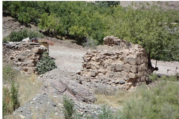
شکل ۱۵: پل ۱ پالنگان (طالب‌نیا، ۱۴۰۰)
