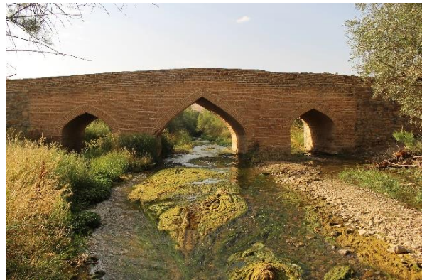
شکل ۱۳: پل گندمان (طالب‌نیا، ۱۴۰۰)
