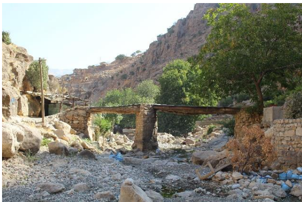
شکل ۱۶: پل ۲ پالنگان (طالب‌نیا، ۱۳۹۷)
