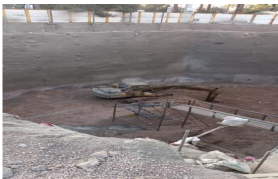
شکل 3. نمایی از پایدارسازی دیواره غربی گود
