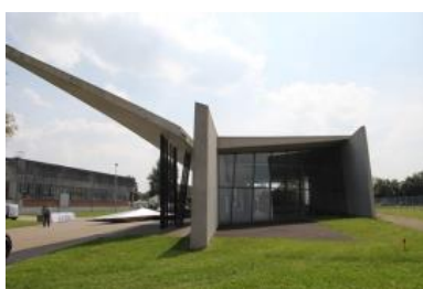
شکل شماره ۱) (ایستگاه آتشنشانی) آلمان
