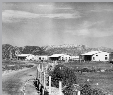
شکل ۲. گوشه ای از یک شهرک مسکونی در مسجدسلیمان،
