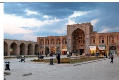
عدم وجود اختلاف ارتفاع در کف مسیرها
