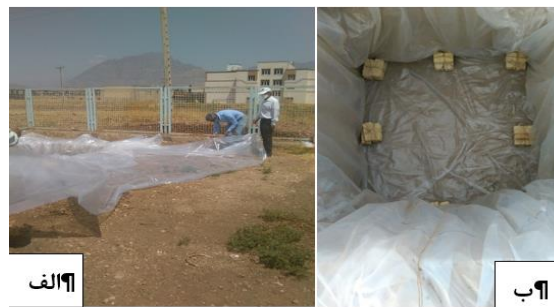
شکل (۳) - مراحل استقرار پلاستیک دولایه در حوضچه (از سمت چپ به سمت راست)
