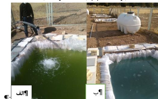
شکل (۴) - مراحل آبگیری حوضچه با مخزن ۲۰۰۰ لیتری (از سمت چپ به سمت راست)
