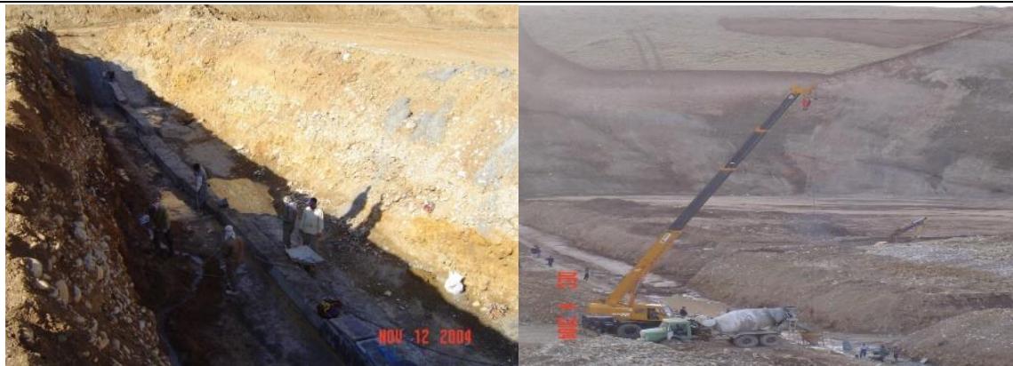
شکل ۲. اجرای پرده آببند سد خاکی ایوشان
