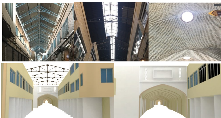
شکل ۵- نورگیری طبیعی و تغییر پوشش سقف در بازار کفاش‌های تهران
