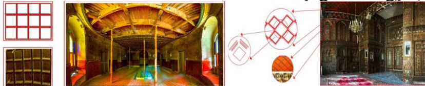
شکل ۱۵: شکل و نوع لمبه کوبی به کاررفته در خانه امام جمعه و استفاده از لمبه کوبی در سقف خانه مستوفی‌الممالک
