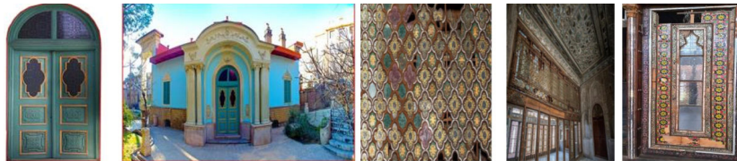
شکل ۸: شکل و نوع آلت چینی چوبی به کاررفته در خانه امام جمعه و نمونه‌ای از آلت چینی‌های چوبی در درب ورودی خانه مستوفی‌الممالک (URL: 1 و نگارندگان، ۱۳۹۸)
