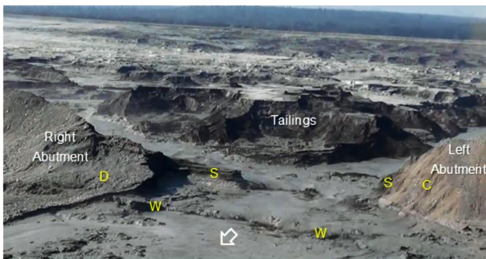
شکل ۹: نمای خرابی سد
