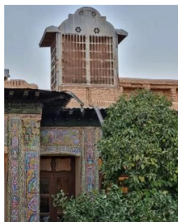
عکس ۶- استفاده از بادگیر در منزل صالحی
